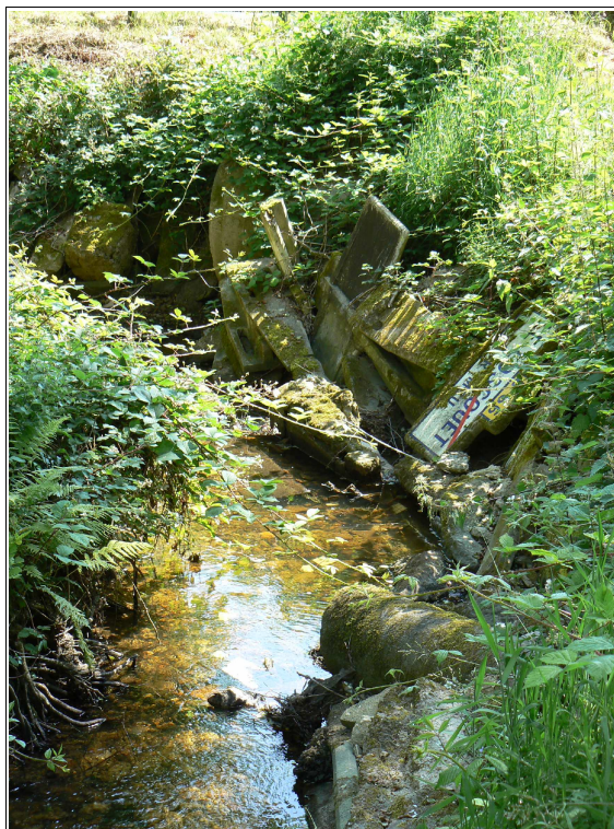
Photo 6: Enrochement tout venant en amont du pont de la D6
