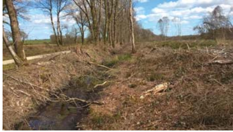
Fossé au nord en bordure de la voie verte
