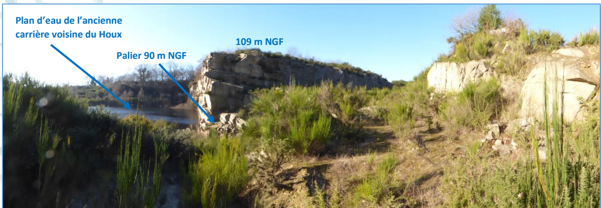
Fig. 8 : Vue n°2 : Fond de fouille
