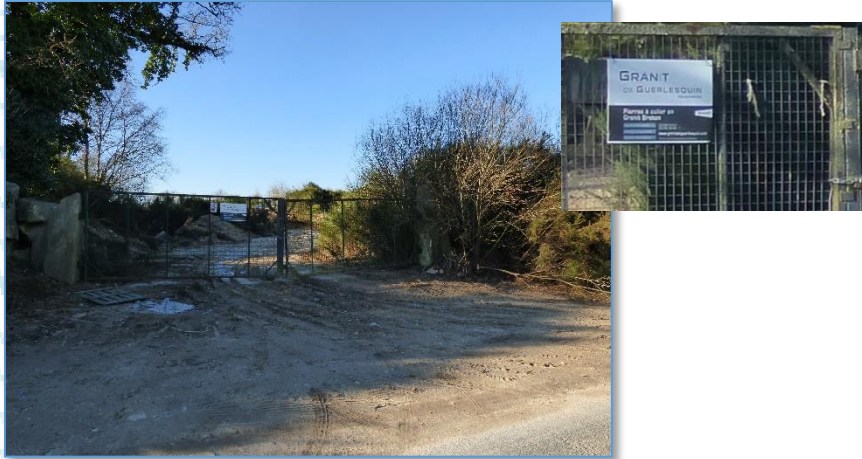
Fig. 7 : Vue n°1 : Accès au site et affichage
