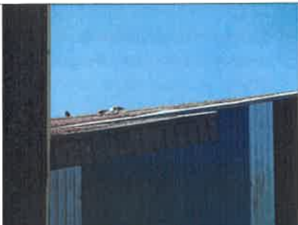
Toit de l'ancien site Jean HUE
