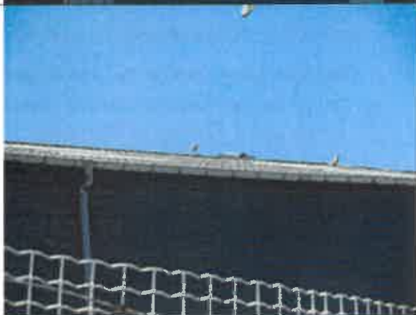
Toit ancien site de livraison Jean HUE rue du Pont Léon
