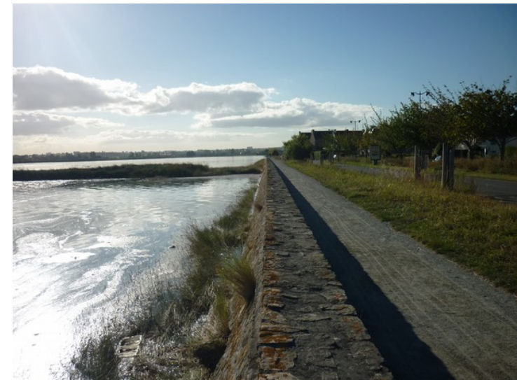
Digue des grèves de Languoux (source : DDTM 22/SRSB/RN)
