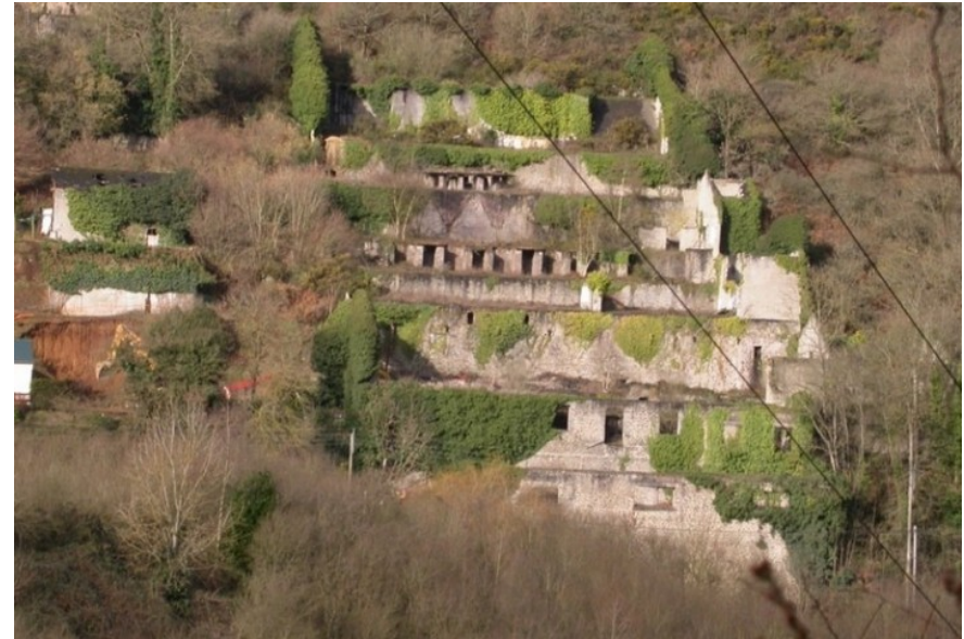
Vue aérienne de la fonderie de Trémuson (source : site officiel de la mairie de Trémuson)
