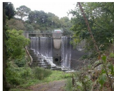
Barrage de Rophémel – Plouasne
