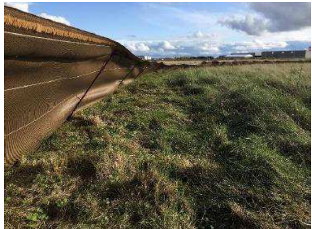
Exemples de filets de protection à sens unique de la petite faune terrestre mis en place au niveau d'un chantier
