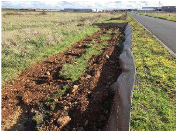
Exemples de filets de protection à sens unique de la petite faune terrestre mis en place au niveau d'un chantier
