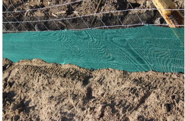
Exemples de filets de protection de la petite faune terrestre mis en place au niveau des clôtures d'un chantier (ATTENTION, il ne s'agit pas ici de dispositifs « à sens unique »)
