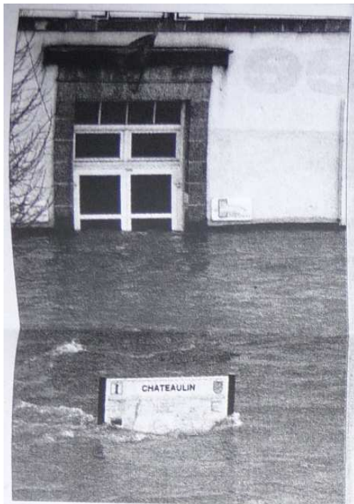
● Image impressionnante que l'Aulne débordant de toute part et inondant largement la mairie. (Photo CP)
