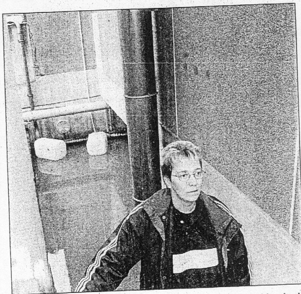
Dans la cage de l'escalier extérieur qui mène à la machinerie de la piscine, la porte d'accès au local a disparu sous les eaux.
