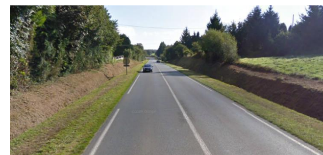
Section limitée à 70 km/h, alignement droit prédominant
