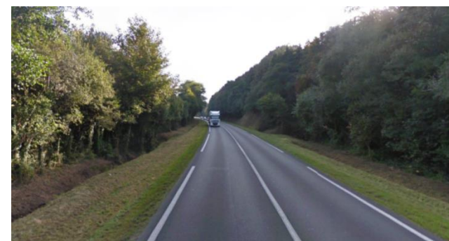
Largeur réduite et effet de paroi entre la RD23 et le giratoire RD790
