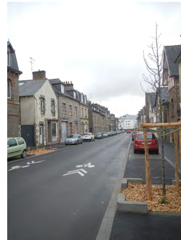
Figure 8 : Rue de la Corderie en janvier 2022 (Source : EGIS, janvier 2022)
