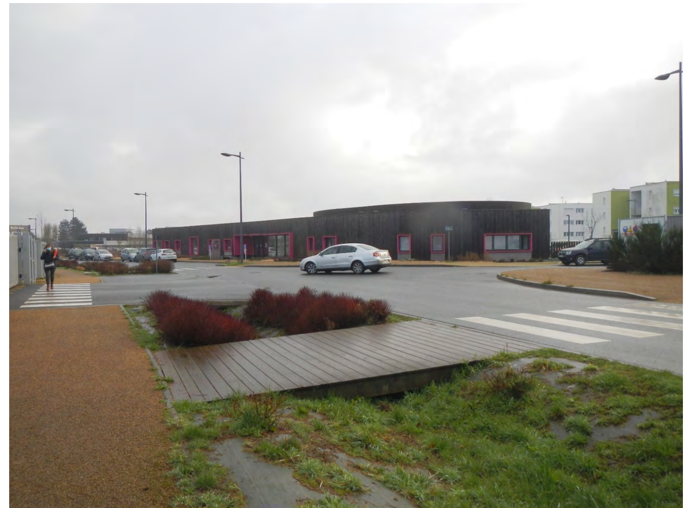
Figure 18 : Avenue des Plaines-Villes à Ploufragan (Source : EGIS, janvier 2022)
