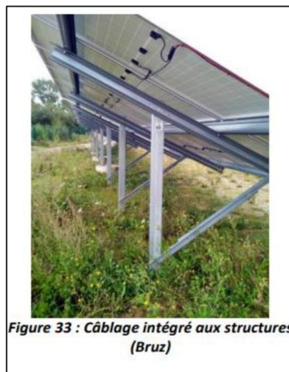
Figure 33 : Câblage intégré aux structures (Bruz)
