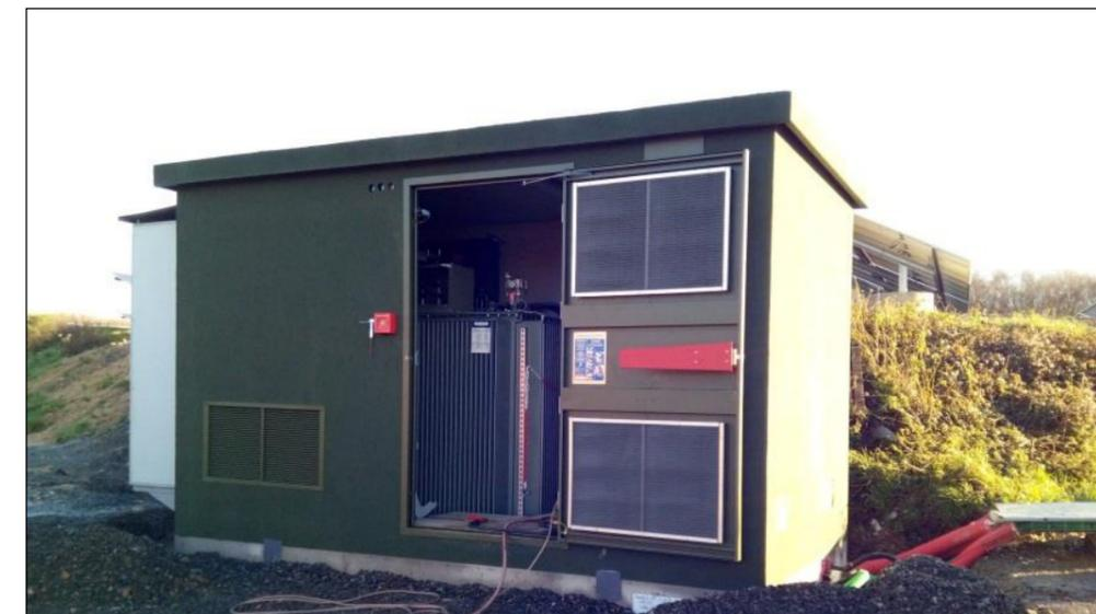
Figure 7: Photo d'un poste de transformation d'un projet en phase de construction (Source : IEL)
