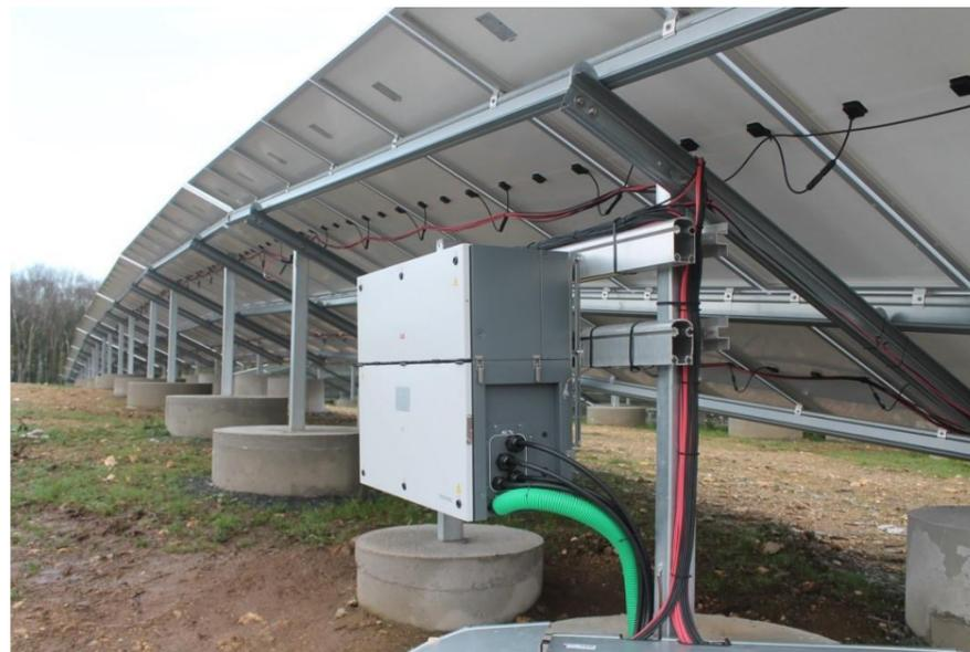
Figure 166 : Photo d'un onduleur d'un projet en phase de construction (FS du Cosquer, ancienne décharge, une réalisation IEL)
