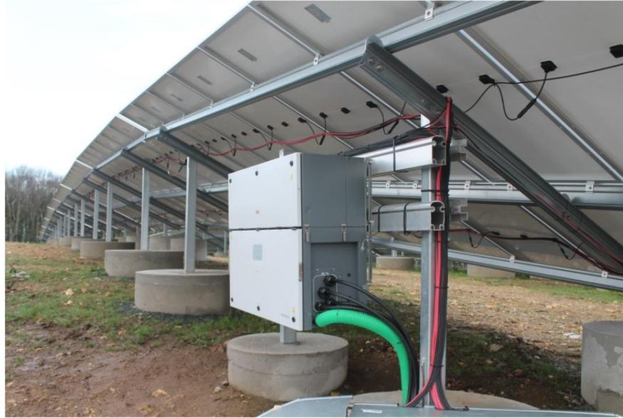
**Figure 1 : Photo d'un onduleur d'un projet en phase de construction
