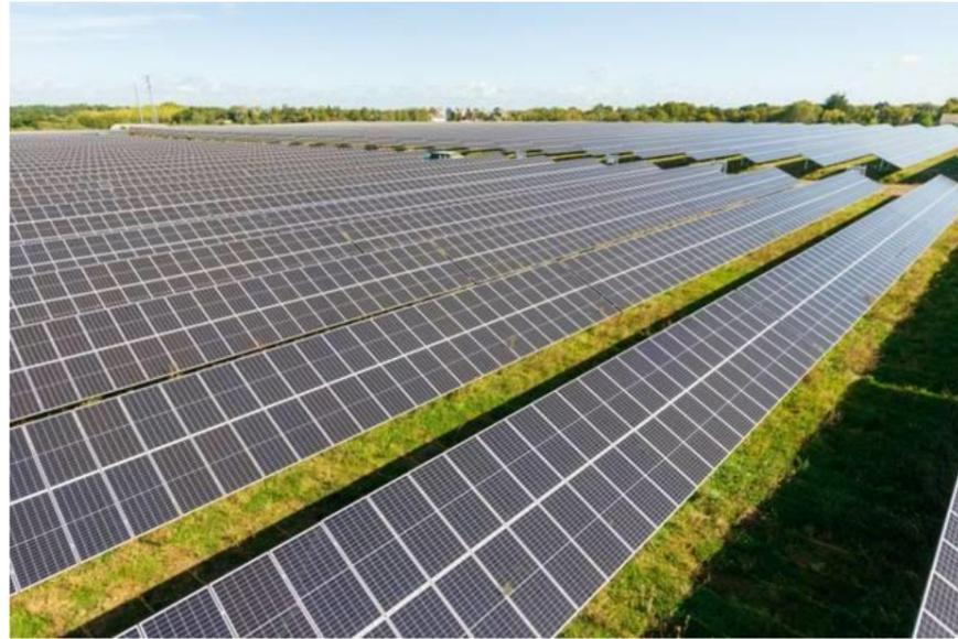
Figure 5 : illustration de l'espacement entre les rangées de panneaux photovoltaïques (FS Marc Energies, une réalisation IEL)
